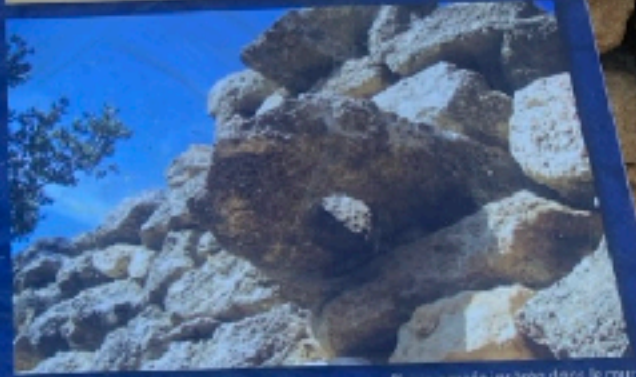
Pierre percée insérée dans le mur
