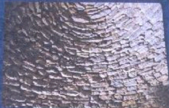
Détail d'une voûte en encastellament
