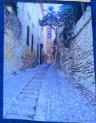
Calade "en pavé régulier" à Gordes où les marches larges et peu hautes accrochent le sabot des animaux.
