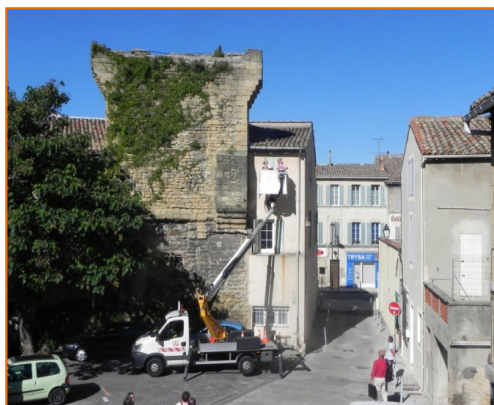
La montée dans la tour avec la nacelle
