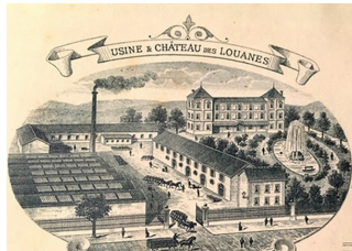
Première construction alors que l'estive et le château des Louanes appartenaient à messieurs Gaillard et Cavallion. En-tête de facture datant de 1892.
